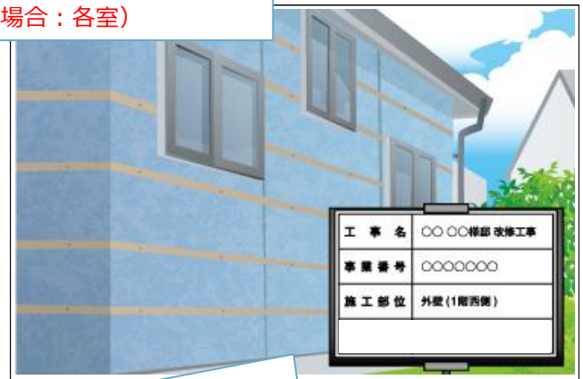
【納】断熱材を重ね貼り施工する場合は、重ねたことがわかるように製品ごとに撮影し、左右に並べて貼り付けてください。
